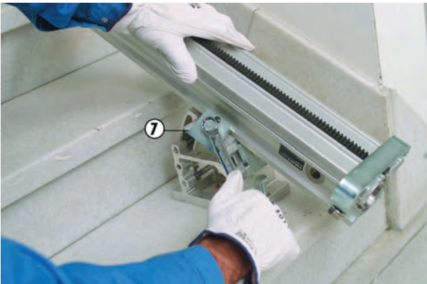
Kiskopukin asennus kun kulma- ja porrassahauksen kiskopukki
