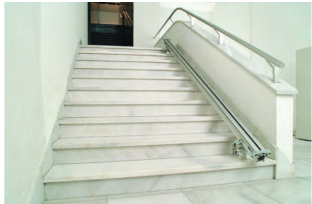
Kiskopukin asennus kun kulma- ja porrassahauksen kiskopukki
