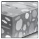
Бетон (без тріщин)
